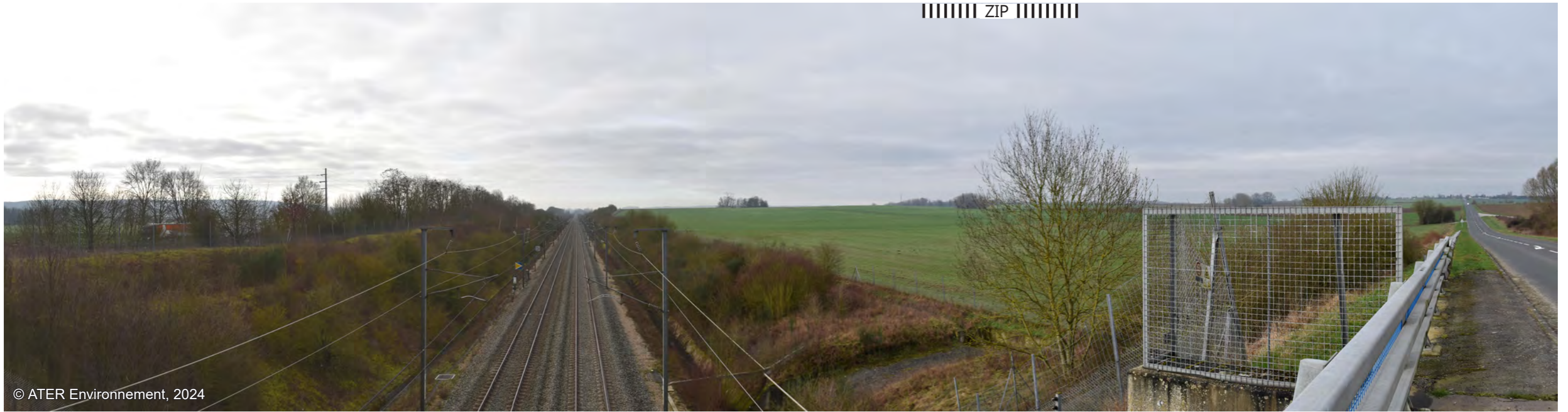
Fig. 78 : Vue sur la LGV Nord-Europe à proximité de l'A1, depuis la D27, au nord-est de l'AER
