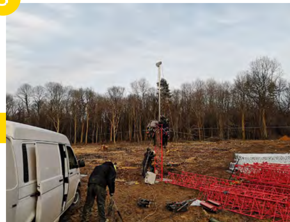
Montage du mât
