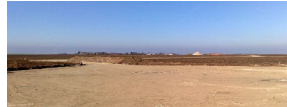
Figure 268 : Exemple d'aire de montage, grave compactée sur géotextile
